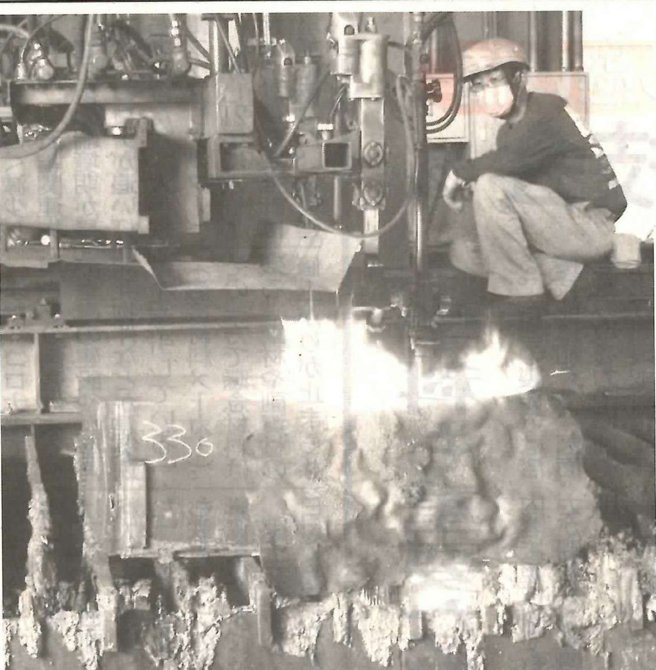
330ミの超極厚板の切断
